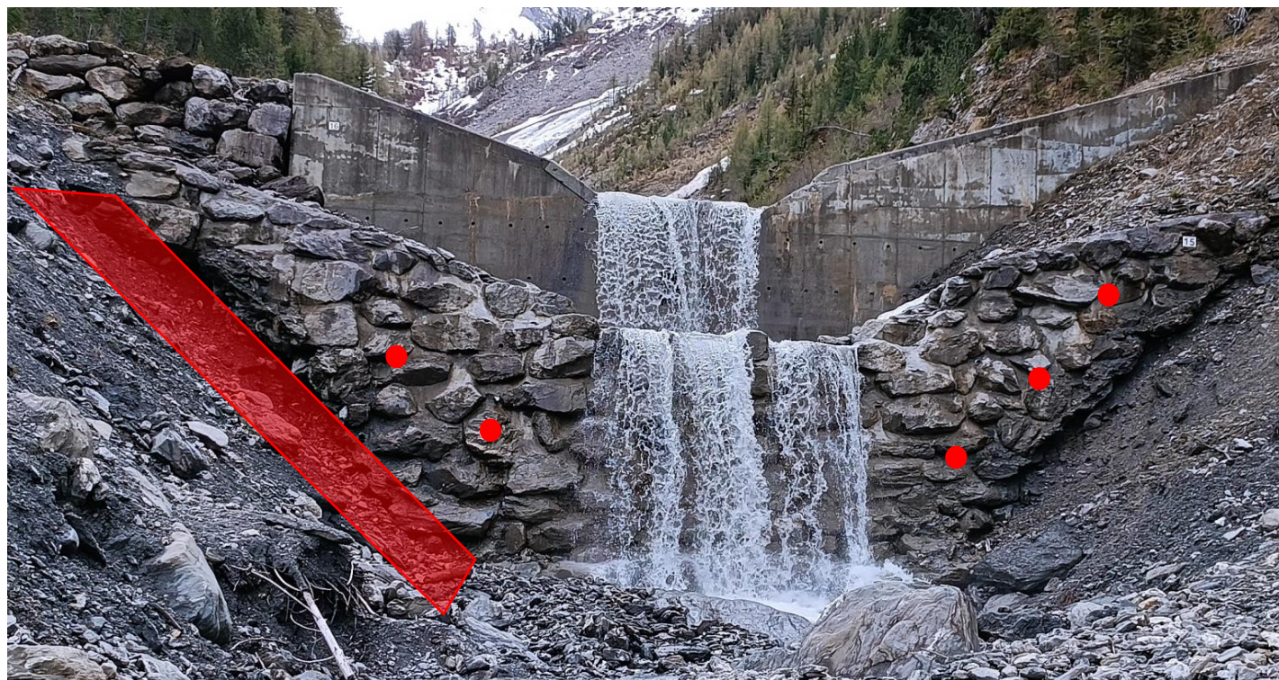
Figure 13 : Implantation schématique des barbacanes à forer et du masque drainant
