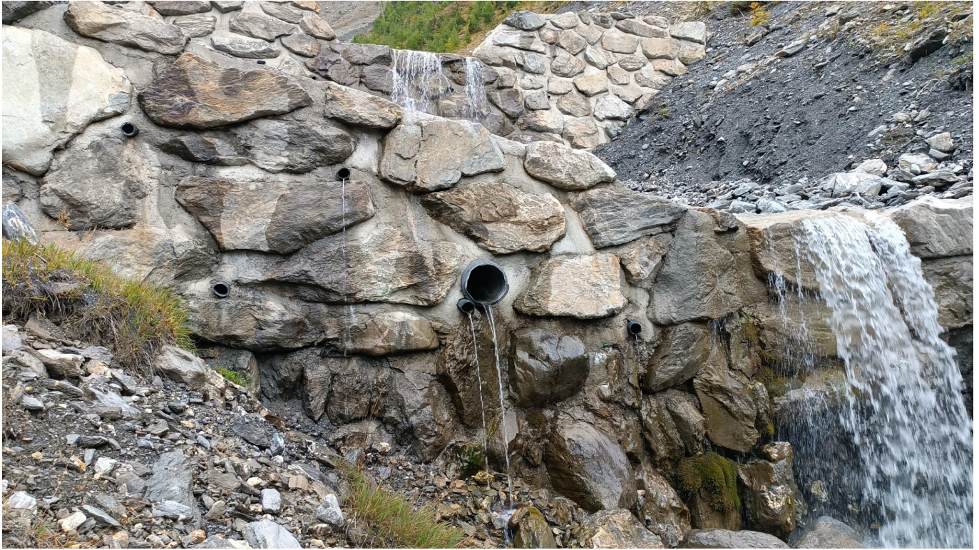
Figure 11 : Buse en pertuis dans l'aile rive droite
