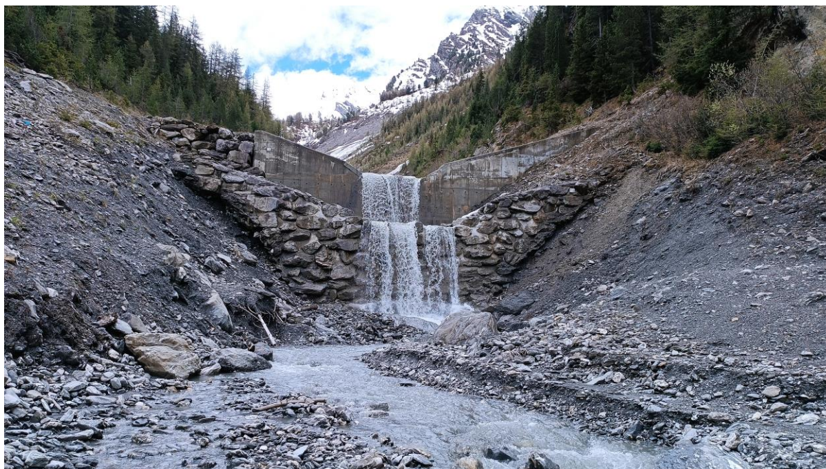
Figure 6 : Ailes affouillées du BA15
