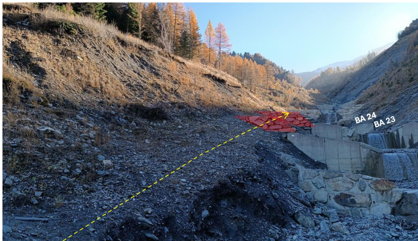
Figure 10 : Ailes rive droite en enrochements secs du BA21 et 22 pouvant être démontées le temps du chantier.
